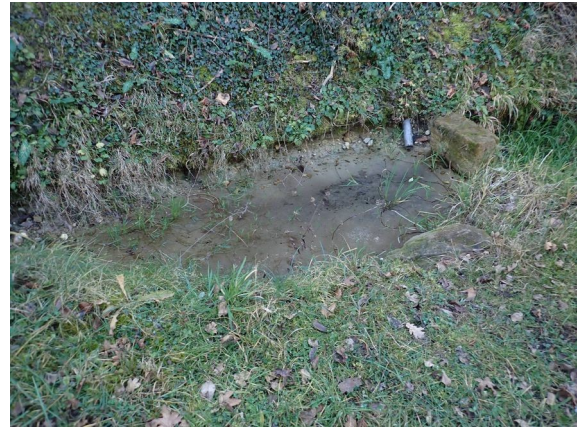
PPE8 redent sur fossé
