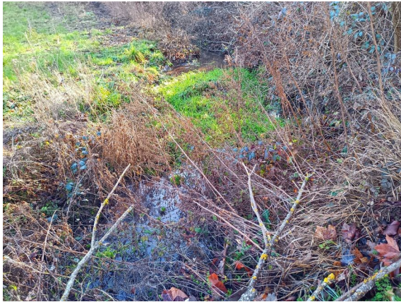
PPE5 fossé atterri
